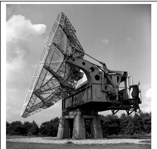
Figuur 4 - De Würzburgspiegel waarmee de eerste 21-cm waarnemingen zijn gedaan. Op de trap Ir. Alex Muller.
